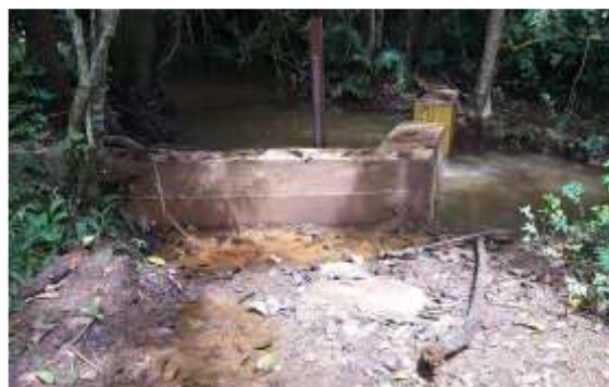
Figura 12 Medidor de vazão em chapa triangular.
