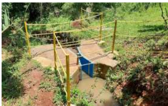
Figura 11 Calha Parshall.
