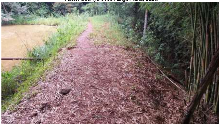
Figura 06 Crista da Barragem Autor: GeoHydroTech Engenharia, 2025.
